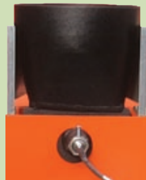
Tipalo dimnih plinov
